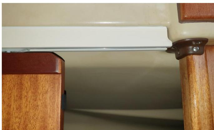
Die neue Schiene mit dem ausgefeilten Abschluss an der Anschlagseite
