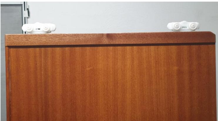
Die fertige Tür mit den Rollenwagen. Durch Ein- oder Ausdrehen der einzelnen Rollenwagen können Höhe und Neigung der Tür eingestellt werden.
