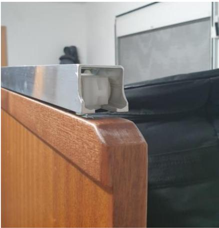
Die abgeschrägte Ecke ist notwendig, damit die Tür bis zum Anschlag geschlossen werden kann
