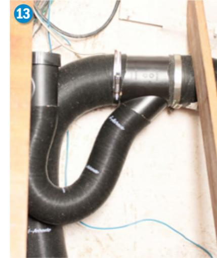
13) Abzweigungen müssen immer in Strömungsrichtung angebracht werden (45 Grad Winkel), sonst saugt die Heizung hier kalte Luft an.
