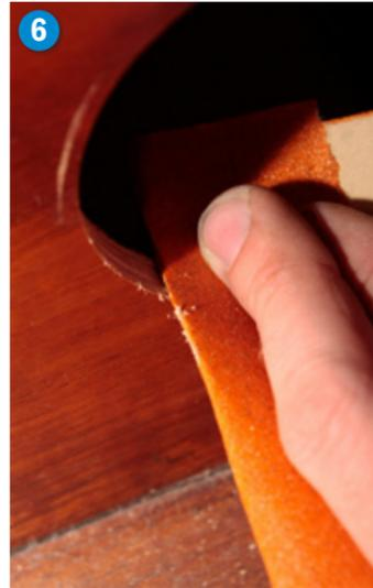
6) Alle Bohrlöcher mit etwas Schmirgelpapier an den Kanten abrunden, damit der Heizschlauch später nicht durchscheuert.
