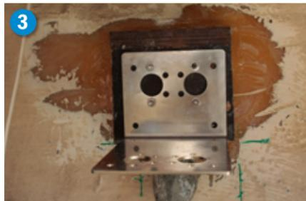
3) ...und anlamiert werden, der eine gerade Platte als Montagefläche bereitstellt.
