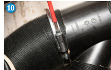
10) Alle Verbindungsstellen müssen mit Schlauchschellen gesichert werden, damit der Schlauch später nicht versehentlich von einer Muffe abrutschen kann.
