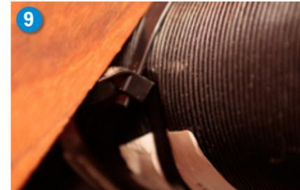
9) Zur Fixierung der Heizleitung genügen große Kabelbinder, die am besten mit einer Öse zum Anschrauben versehen sind.
