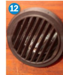
12) Mindestens ein Ausströmer im System sollte jedoch nicht verschließbar sein, um einen versehentlichen Luftstau im Rohr und eine Überhitzung der Heizanlage zu vermeiden.
