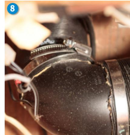
8) An engen Verbindungsstellen lassen sich Knicke im Rohr nur durch vorgefertigte Winkelstücke vermeiden.
